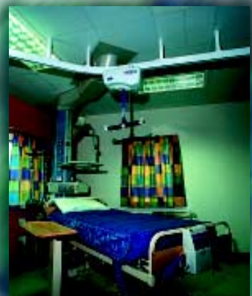
La grúa Wispa se coloca fácilmente para permitir el paso de la cama a la silla o de la cama a la camilla, y puede facilitar el cambio de postura de los pacientes hasta una posición vertical.
